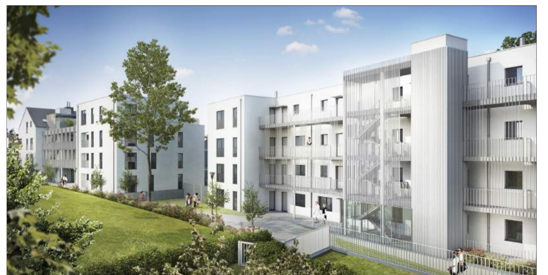
Außenliegende Gänge werden in die Wohnungen führen, und auch der Aufzug wird außerhalb des Gebäudes verlaufen.
