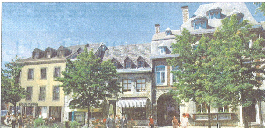
Den erforderlichen Nachbesserungen fiel eine Ebene im Eckhaus zum Marktplatz zum Opfer. Das Gebäude wirkt nun nicht mehr so massiv, auch wenn es etwas höher ist als das angrenzende Haus Mertens.
